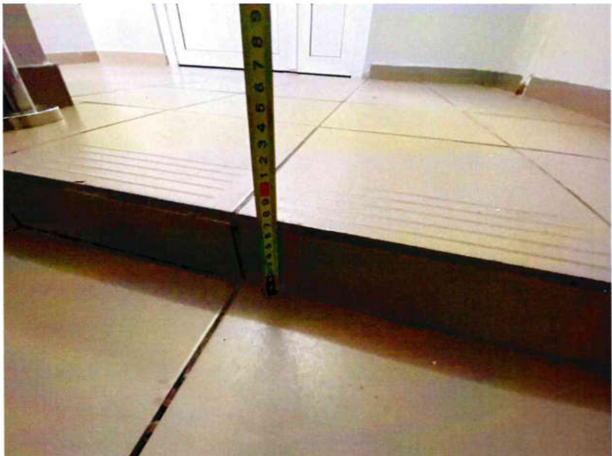
Рисунок 3.9 Высота ступени 7 см
