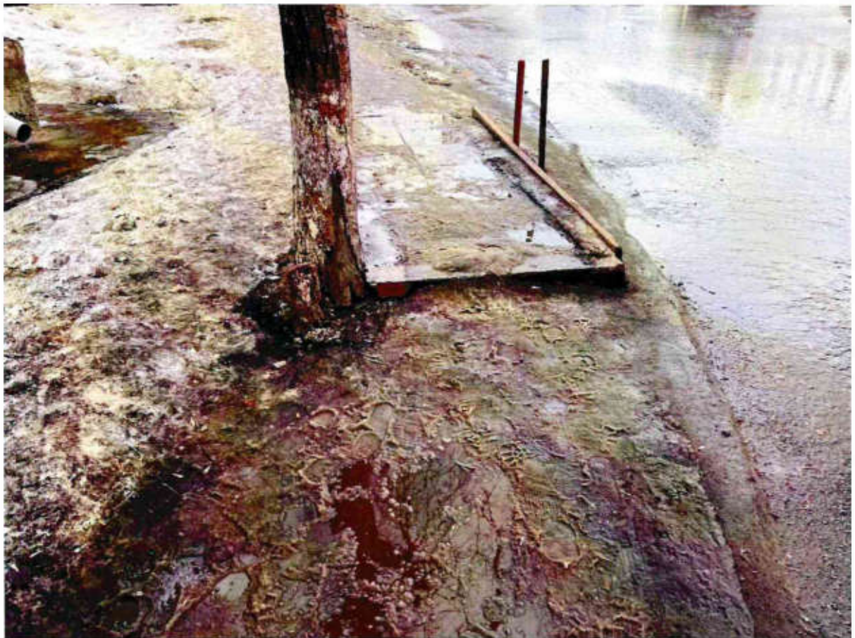
Рисунок 1.3 Перепад высоты на путях движения к объекту
