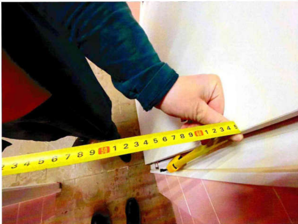
Рисунок 5.8. Ширина дверного проема 65 см
