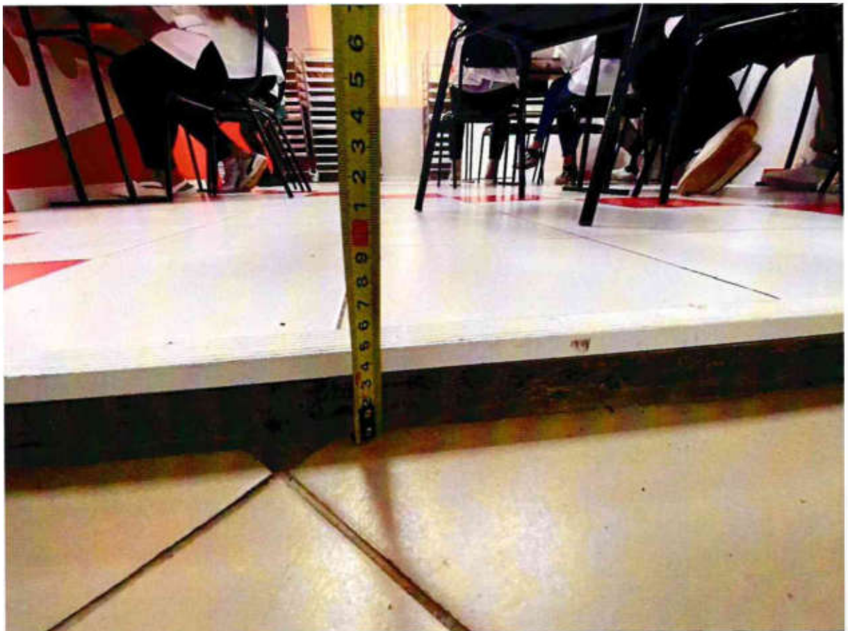
Рисунок 4.2. Высота порога при входе в кабинет 5 см
