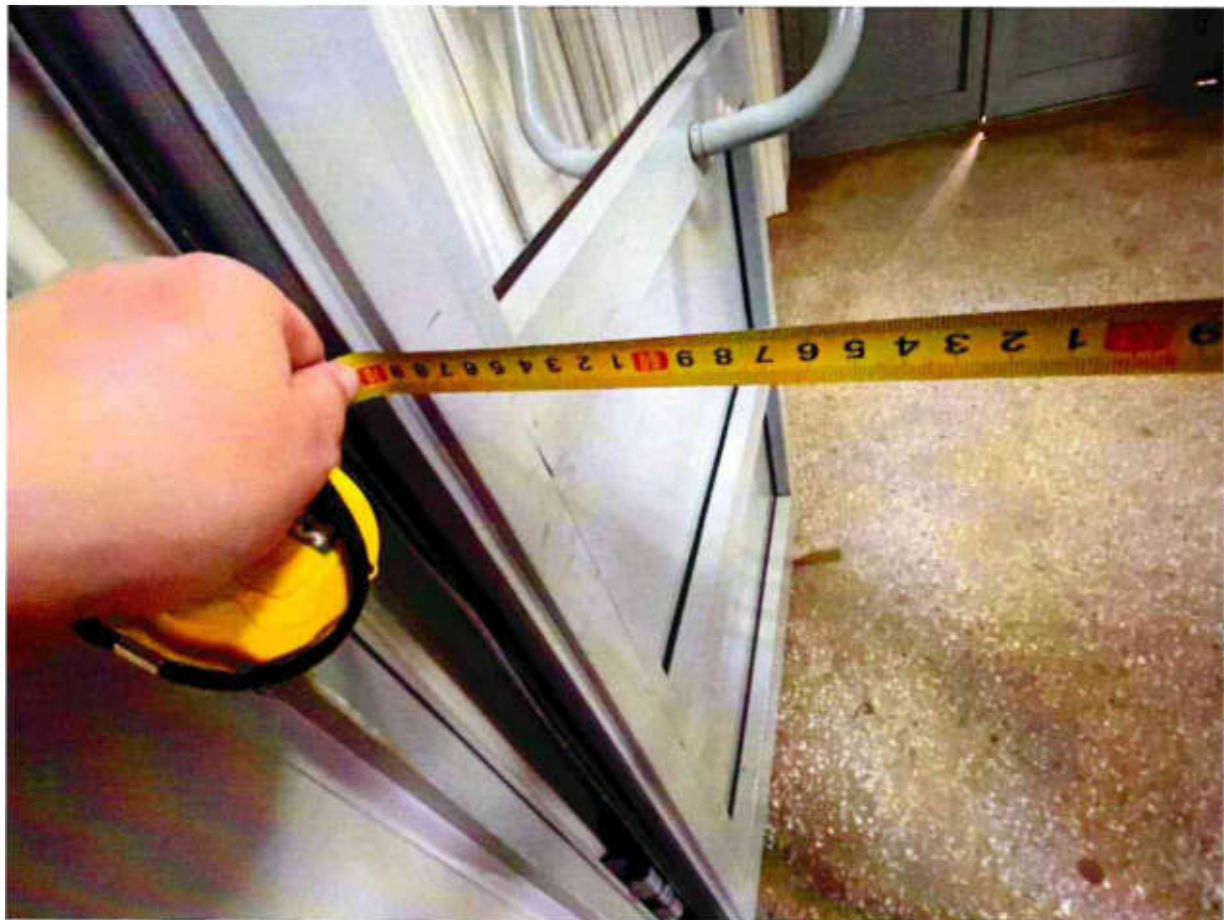
Рисунок 2.10 Ширина одной створки 70 см
