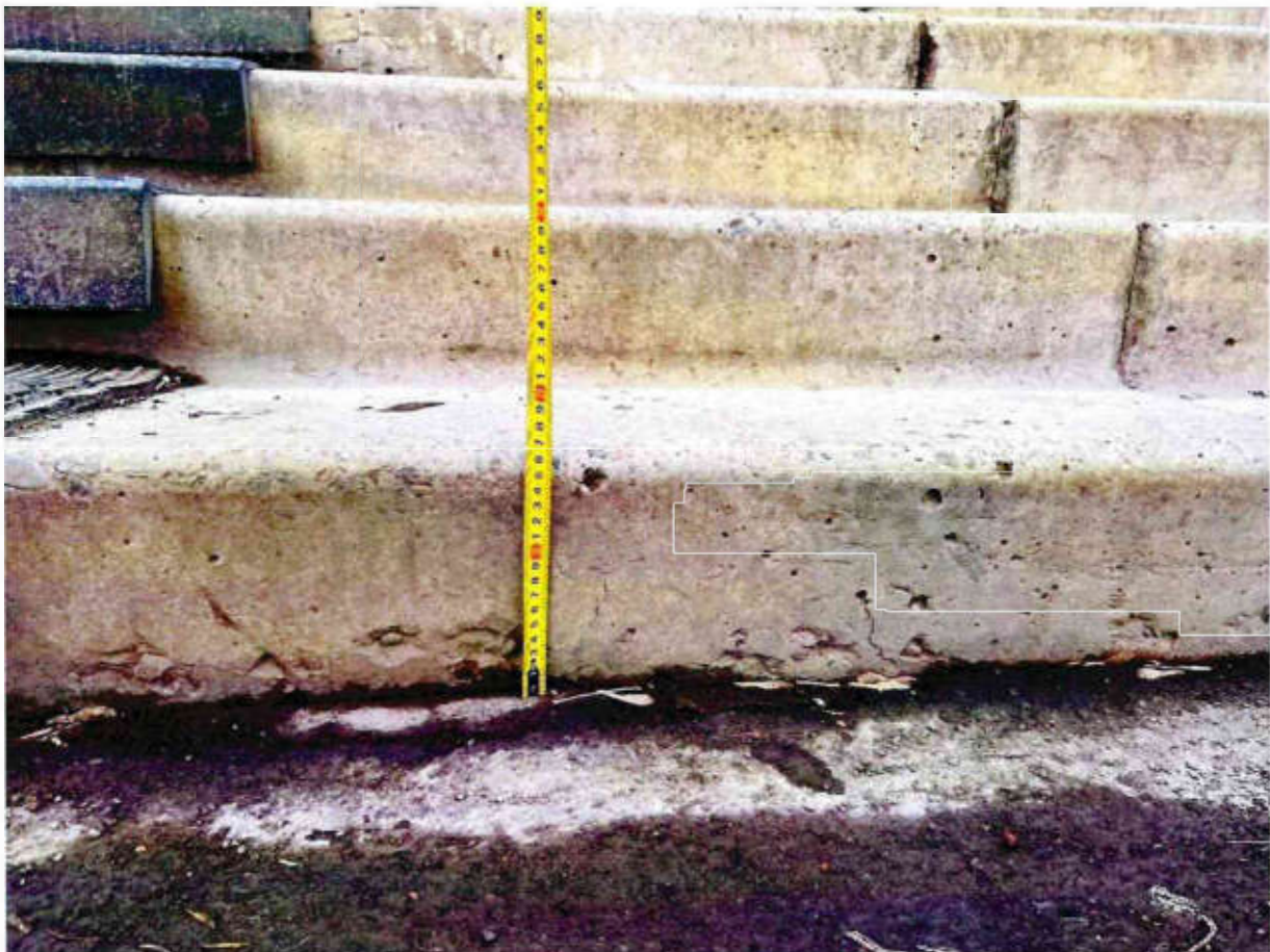
Рисунок 2.3 Ступени лестничного марша имеют разную высоту (16 см)
