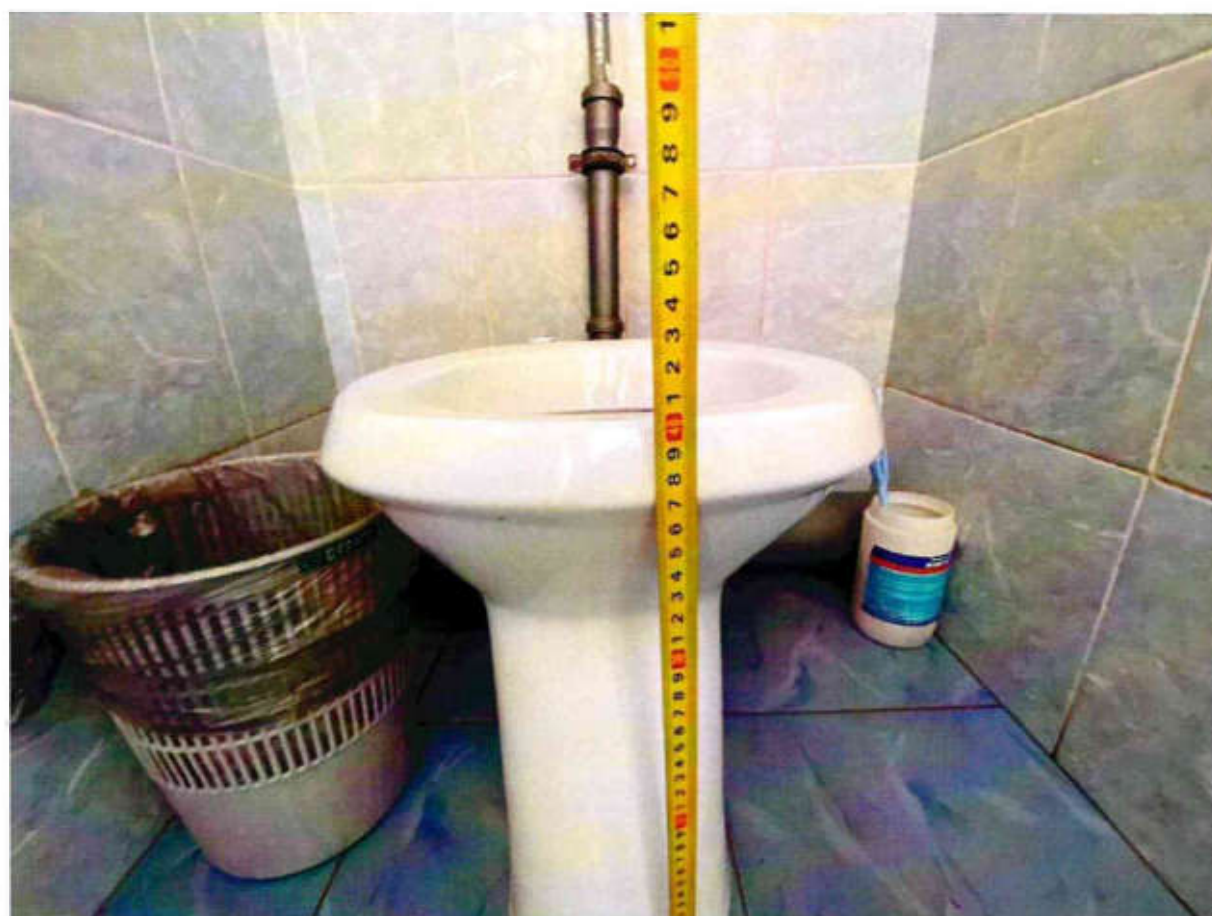
Рисунок 5.3. Высота унитаза 40 см
