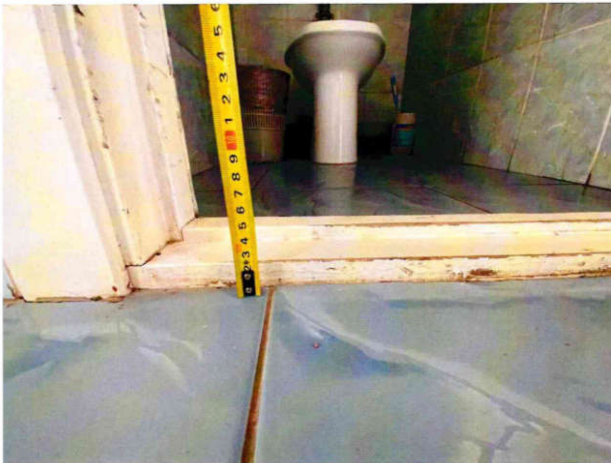
Рисунок 5.4. Высота порога 4 см
