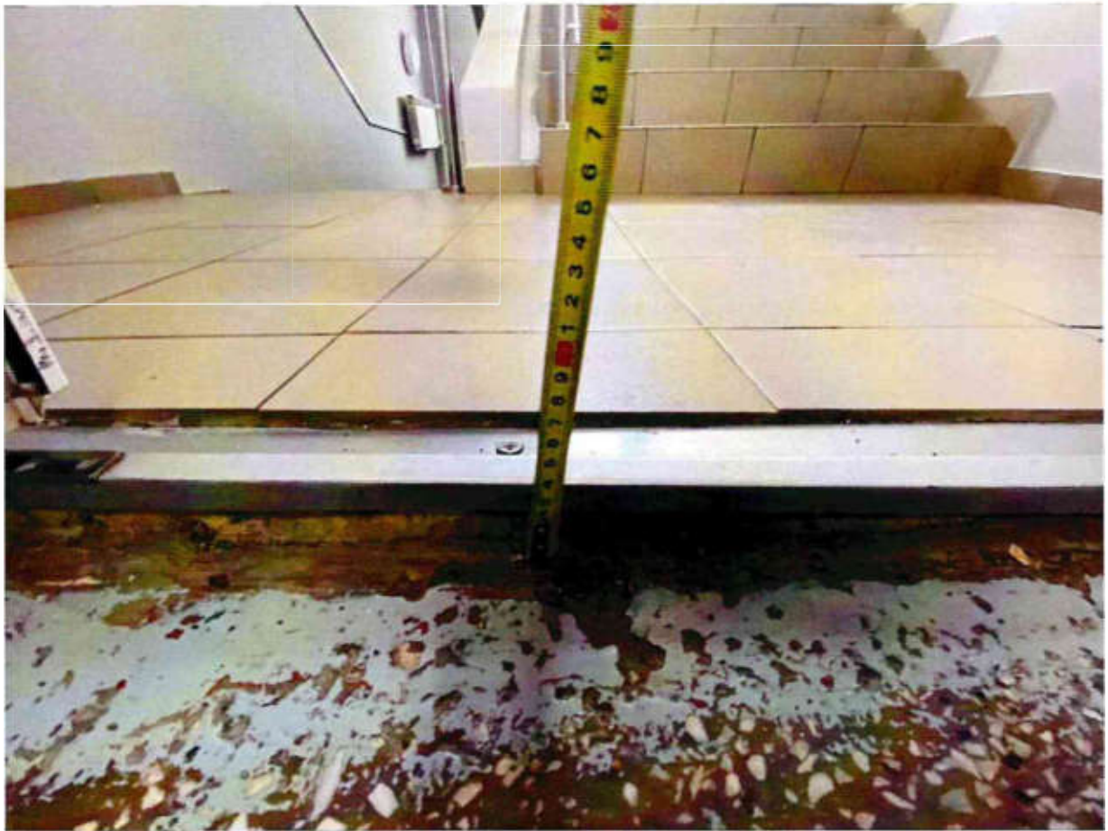
Рисунок 3.16 Высота порога 4 см
