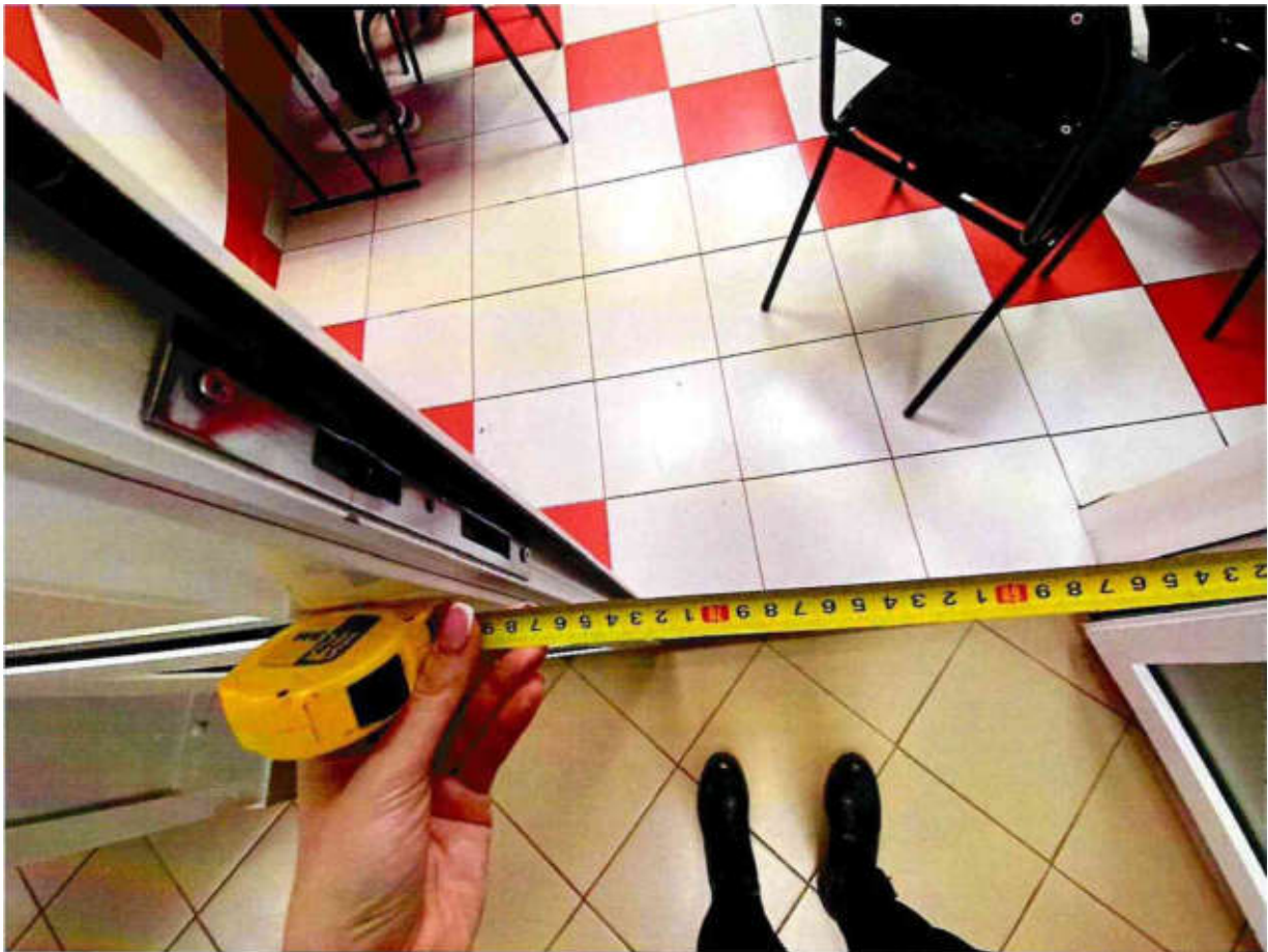
Рисунок 4.3. Ширина дверного проема 79 см (при открытии одной дверной створки)
