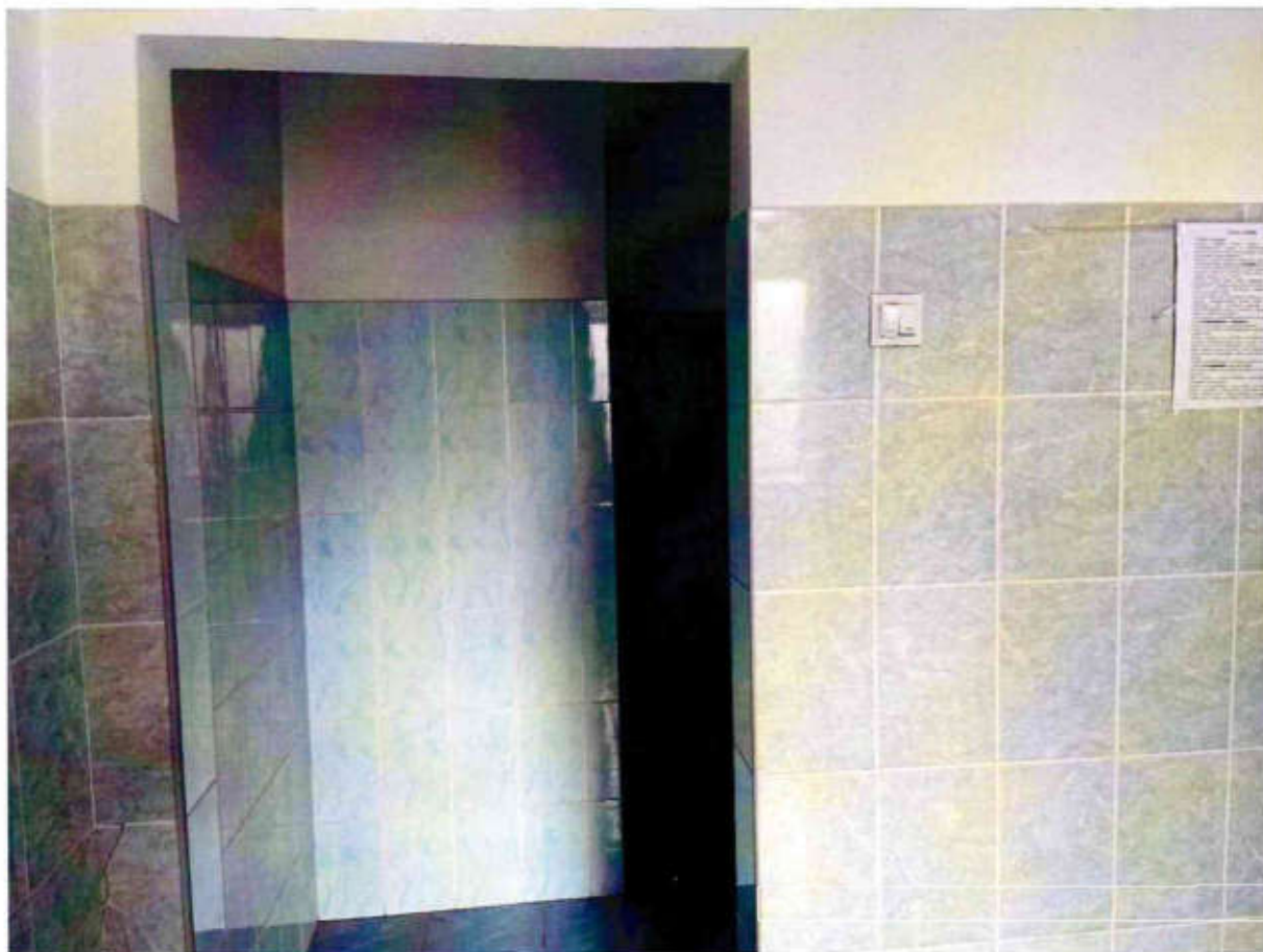
Рисунок 5.5. Выключатель находится на недоступном уровне для людей на креслах-колясках
