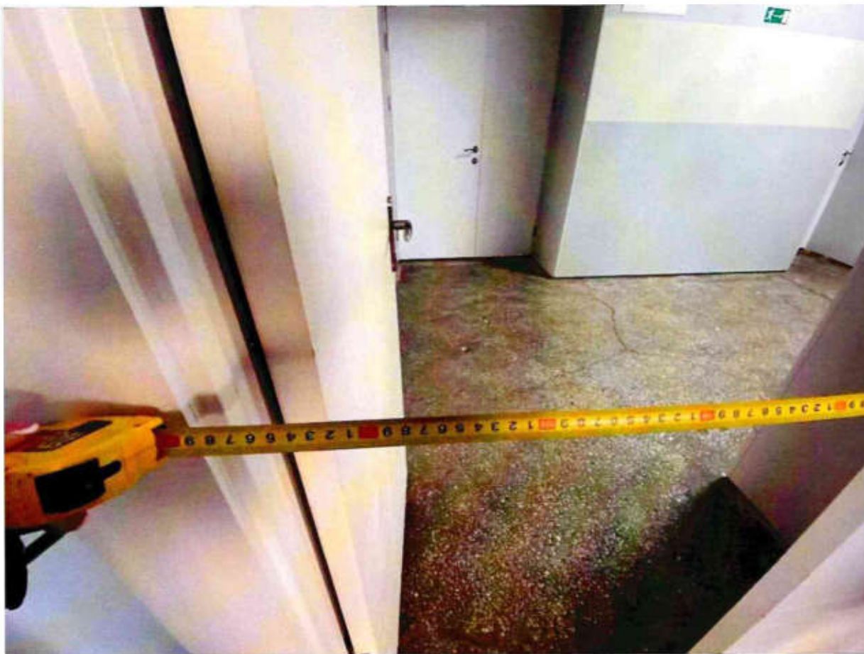
Рисунок 4.7. Ширина дверного проема при открытии двух створок 132 см
