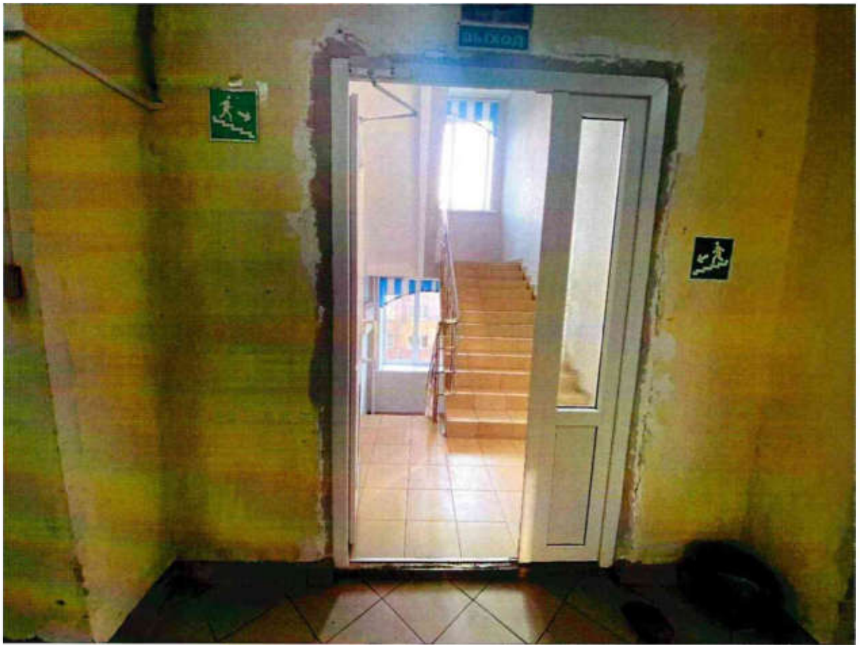
Рисунок 3.20 Двери на путях движения к лестничному маршу
