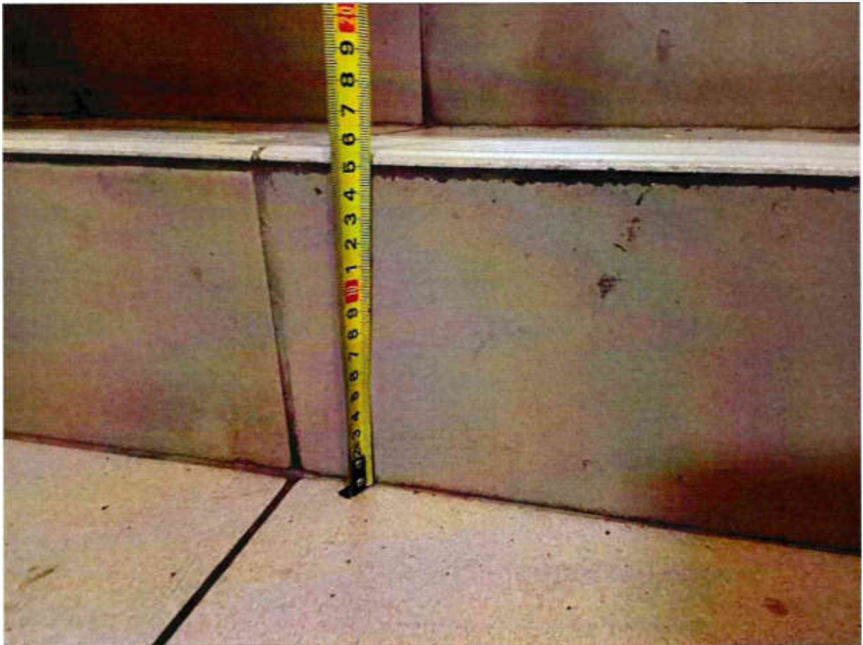
Рисунок 3.8 Высота ступени 15,5 см
