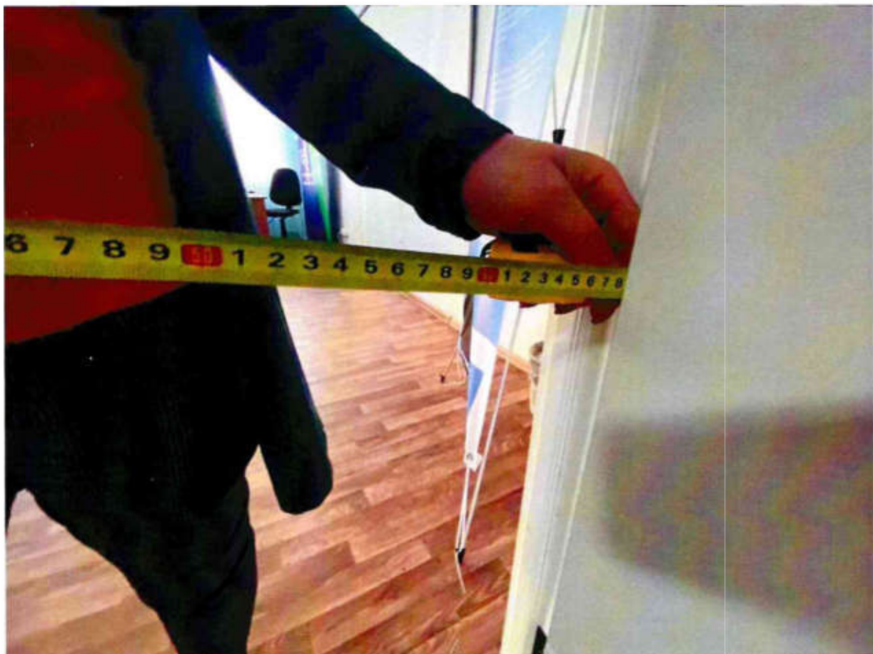
Рисунок 4.6. Ширина дверного проема 68 см (при открытии одной дверной створки)
