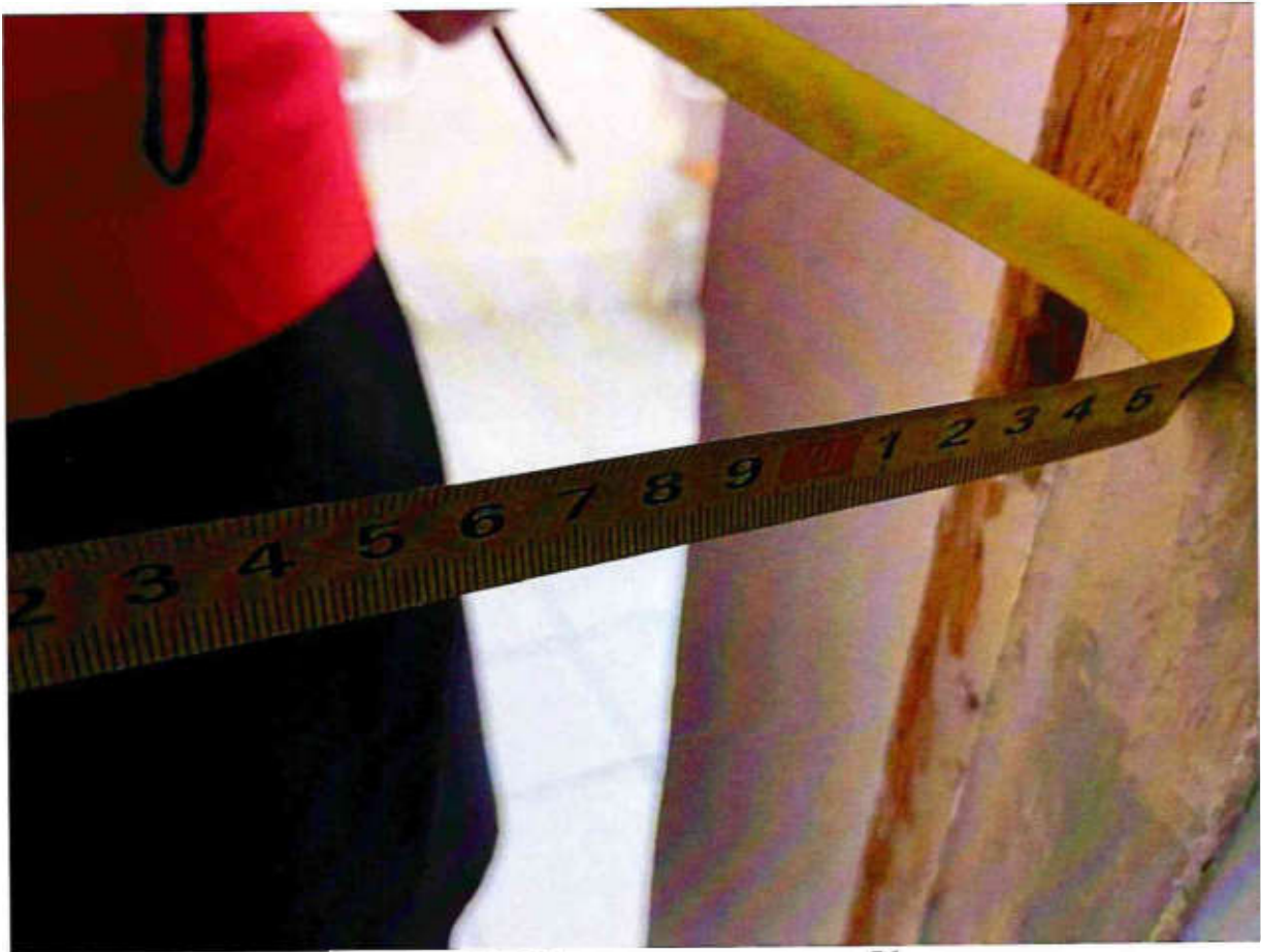
Рисунок 5.12. Ширина дверного проема 76 см
