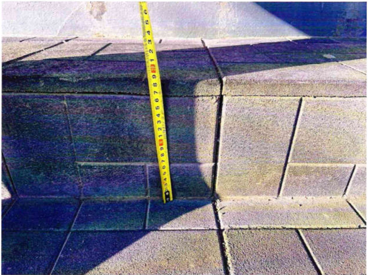
Рисунок 2.3 Ступени лестничного марша имеют разную высоту (19 см)
