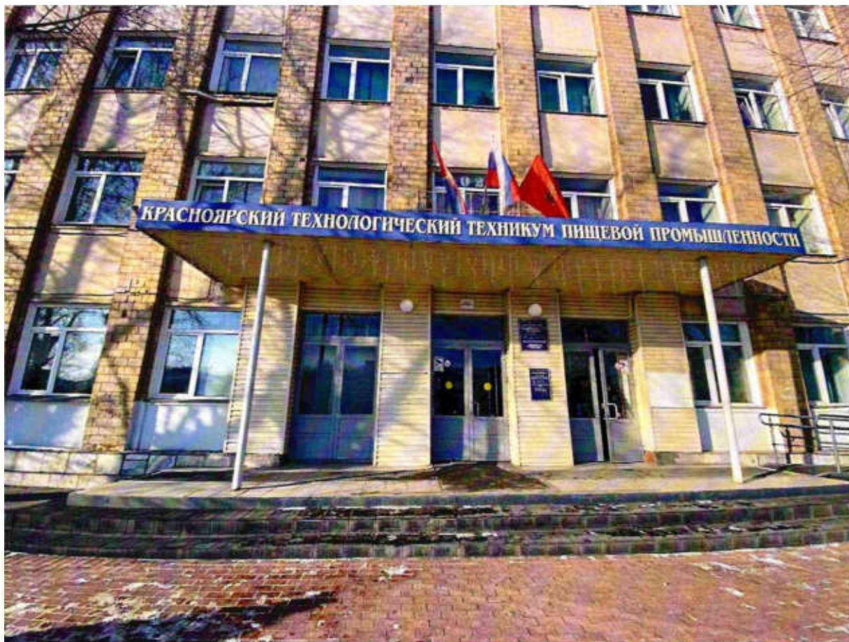
Рисунок 2.1 Лестничный марш при входе на объект
