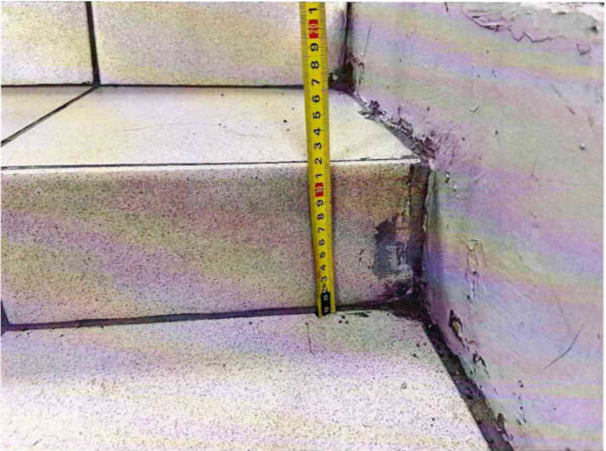
Рисунок 3.8 Высота ступени 12 см
