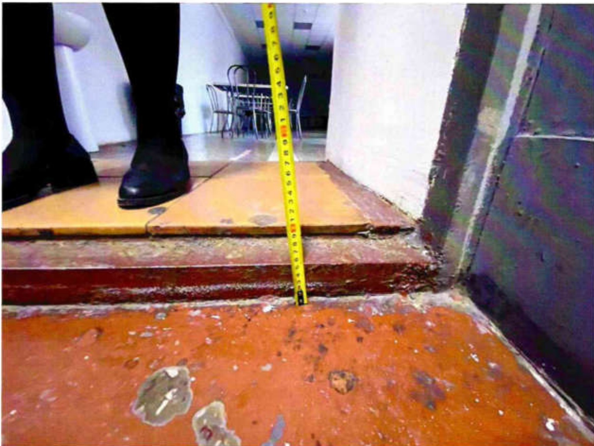
Рисунок 4.14. Высота порога при входе в столовую 7 см
