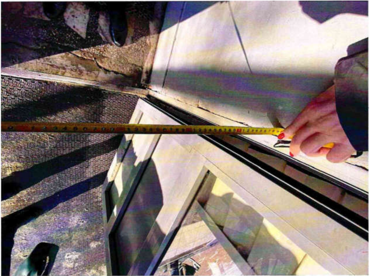
Рисунок 2.11 Ширина одной створки 75 см
