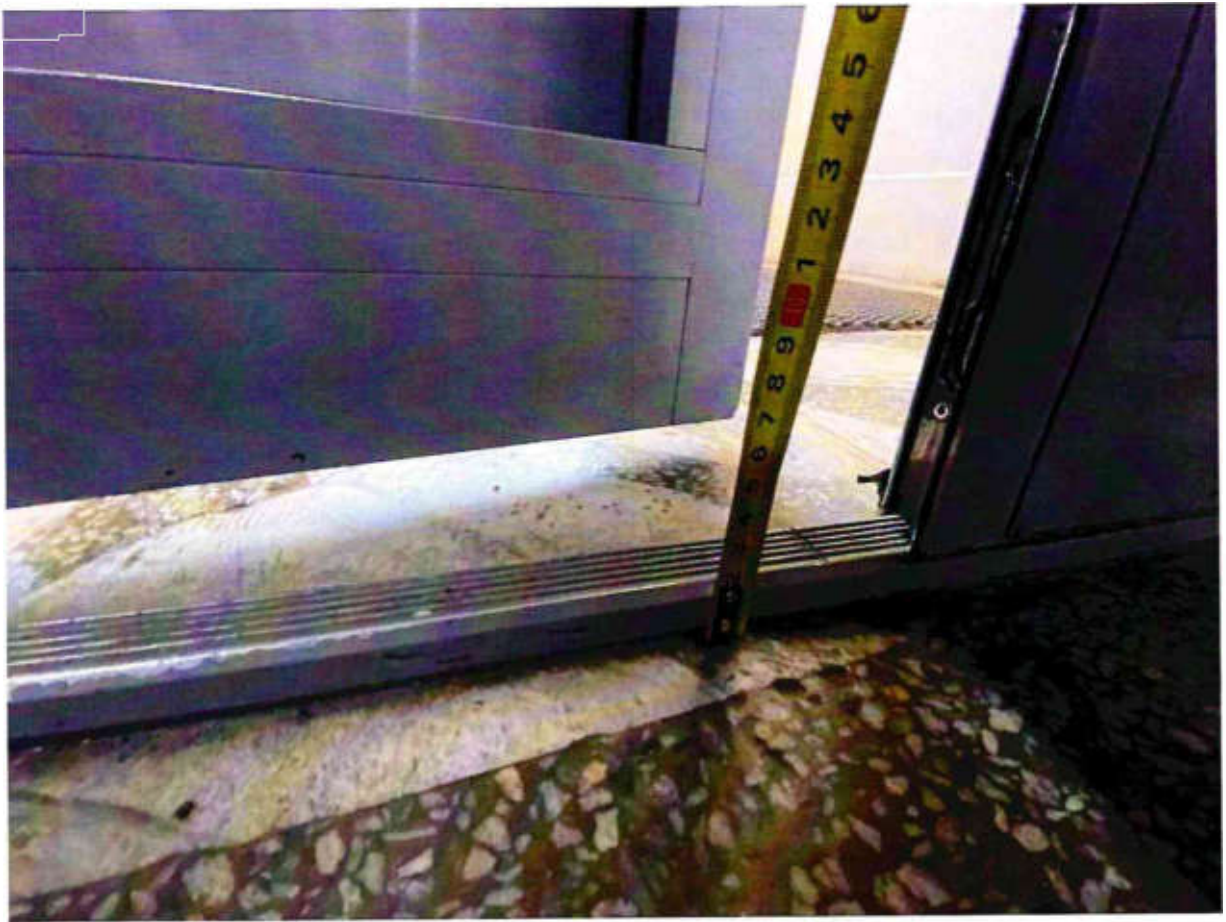
Рисунок 2.17 Высота дверного порога 2 см
