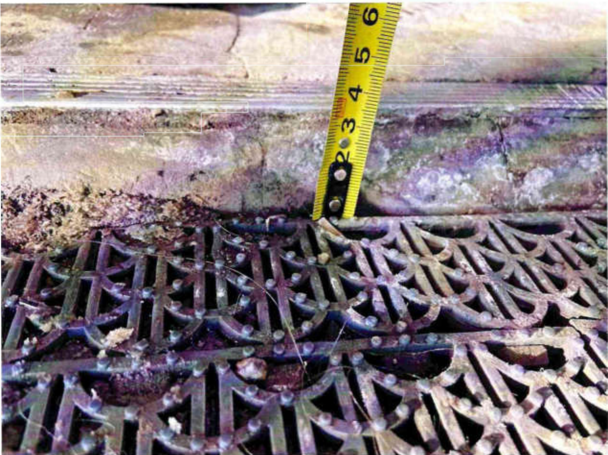
Рисунок 2.12 Высота дверного порога при входе 3,5 см
