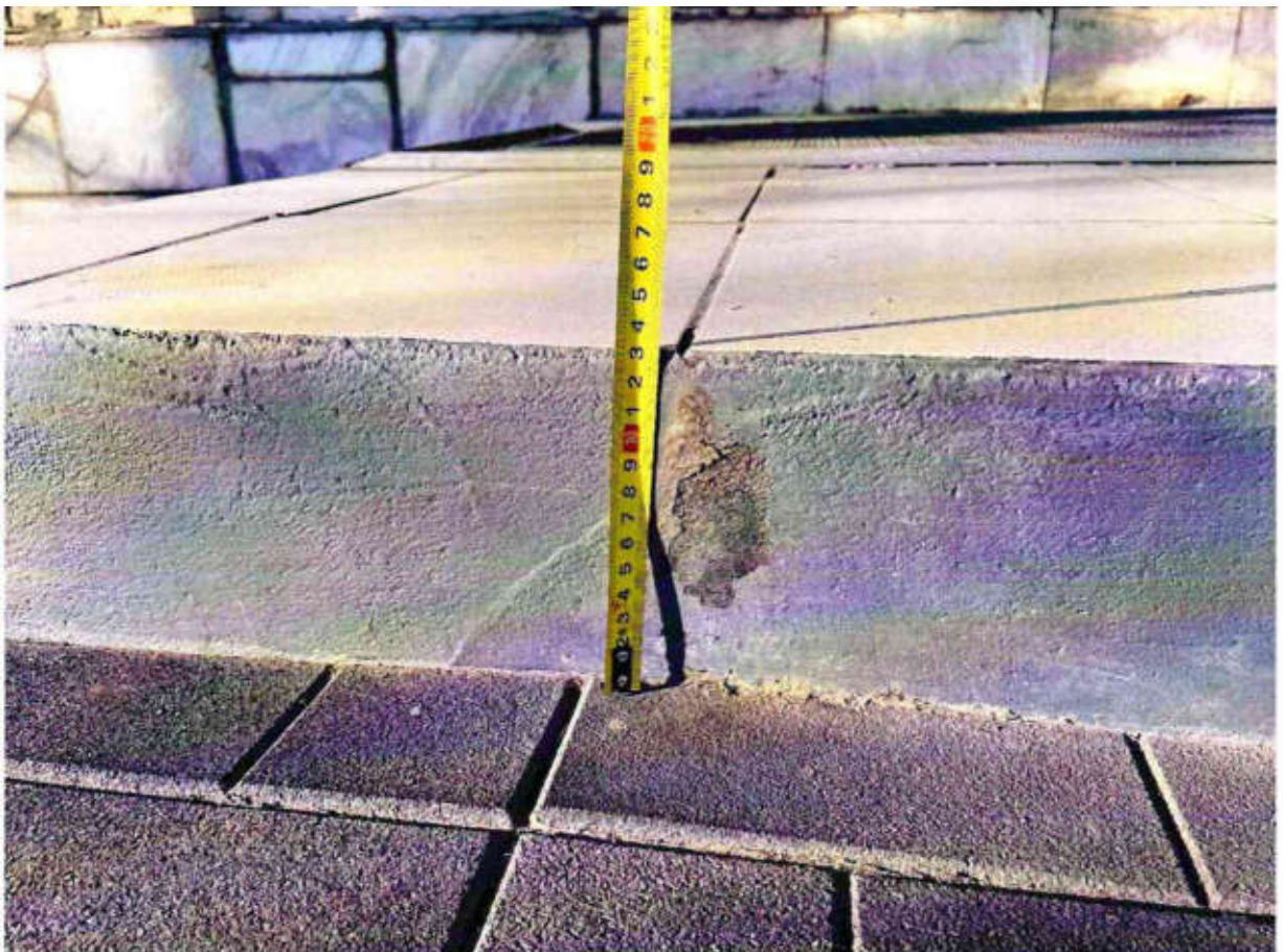
Рисунок 2.4 Ступени лестничного марша имеют разную высоту (13 см)
