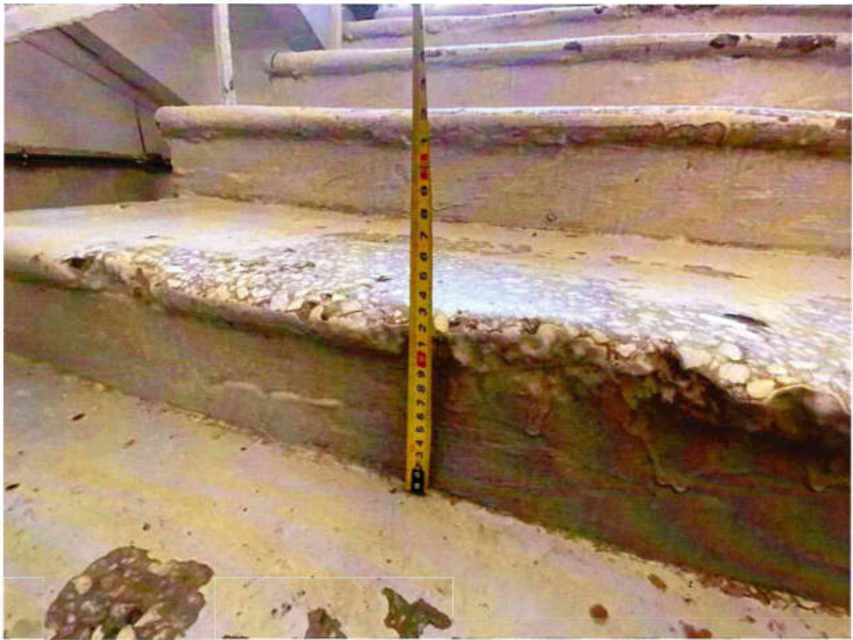
Рисунок 3.11 Высота ступени 12 см
