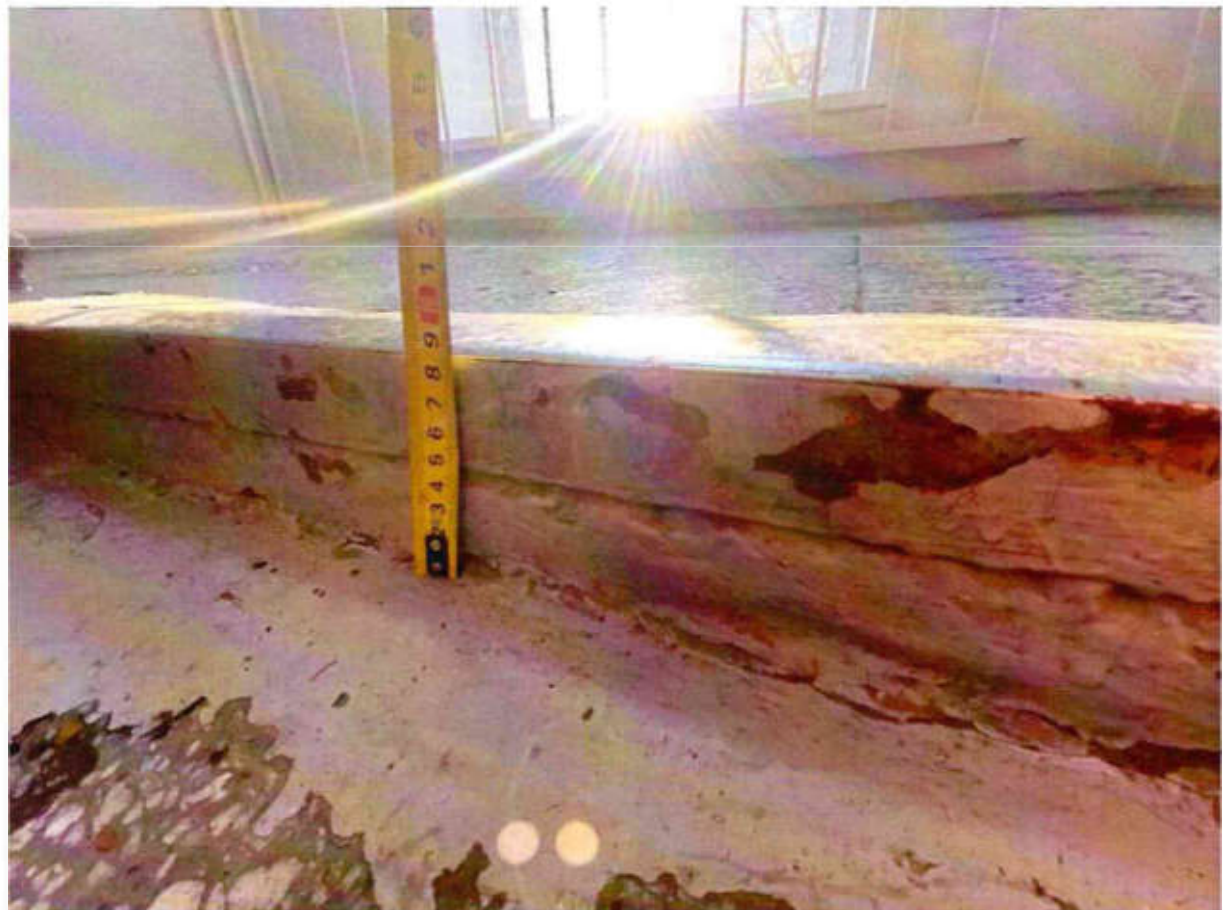
Рисунок 3.12 Высота ступени 8,5 см
