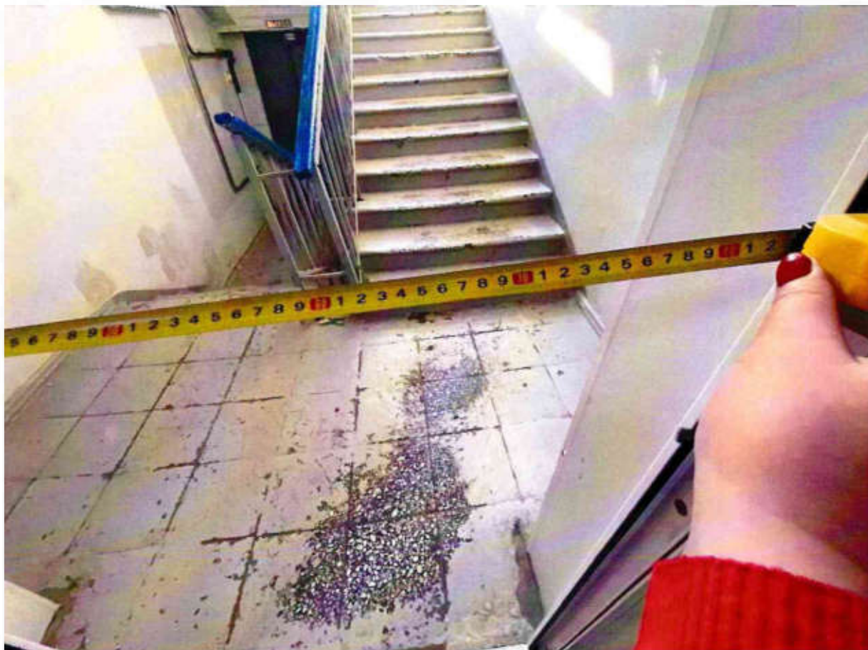
Рисунок 3.16 Ширина дверного проема 83 см
