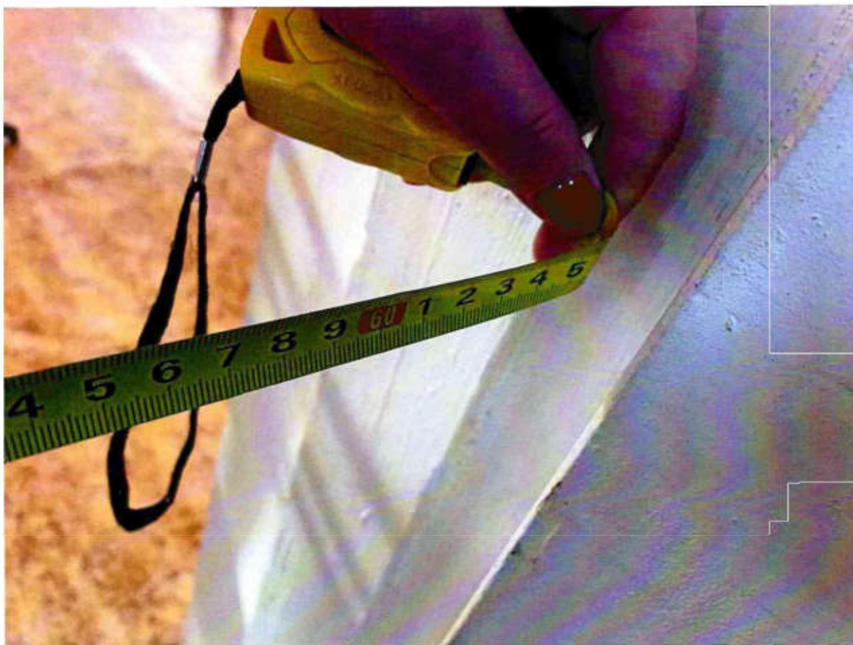
Рисунок 4.3. Ширина дверного проема 65 см (при открытии одной дверной створки)
