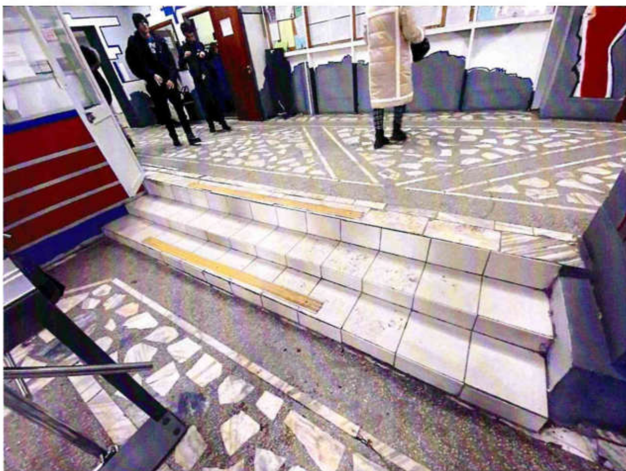
Рисунок 3.6 Лестничный марш на первом этаже здания
